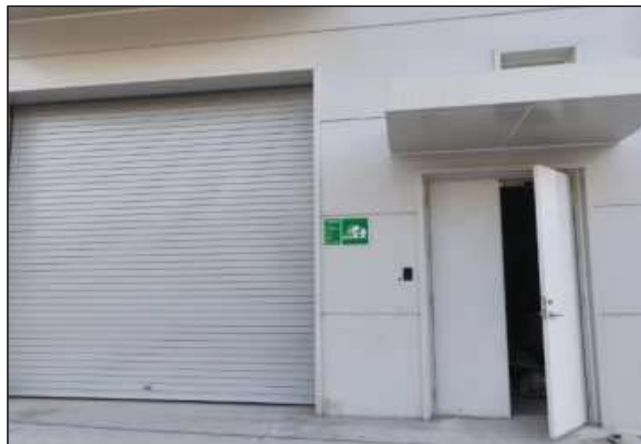
一般固废暂存间
